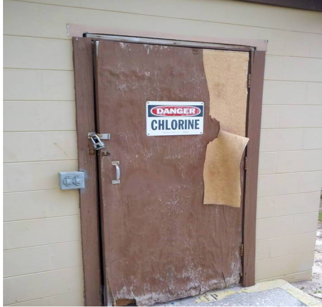
Jacob WTP chlorine room door
