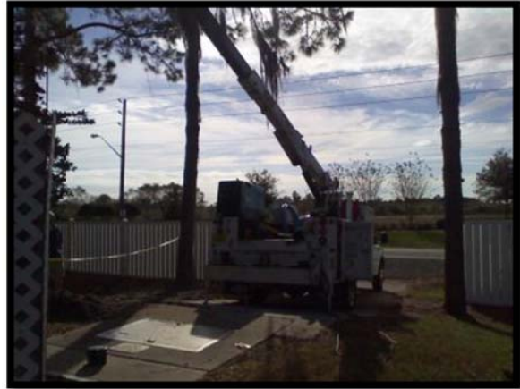
Work at Liftstation #10
