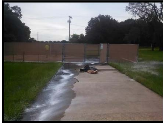
Voyles Loop liftstation overflow.
